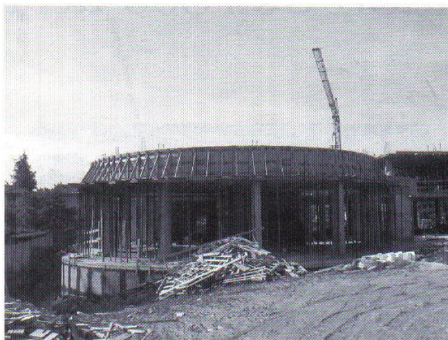
Il motel in costruzione ad Oleggio Castello
